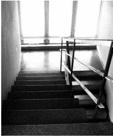
Escaleras de acceso a las dependencias superiores.
